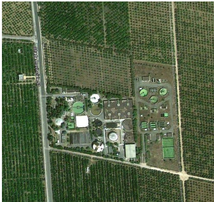
Impianto di depurazione "Loc. Mazzarelle"
