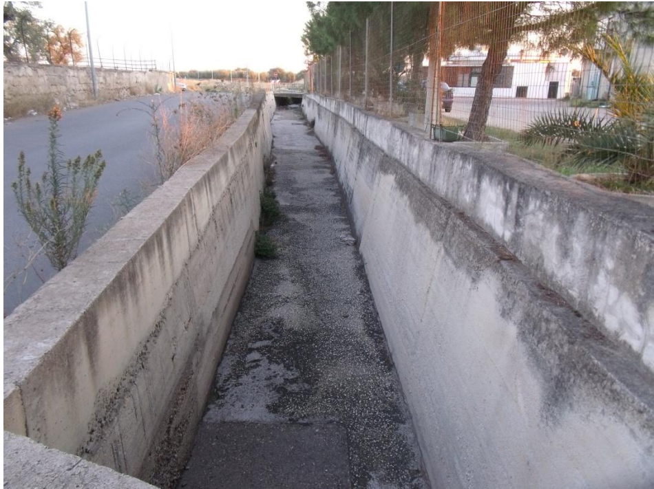
Particolare della canalizzazione canale Patemisco – Gravina San Marco
